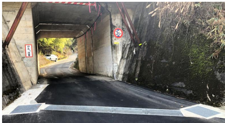
長野県 南木曽町役場 道路改良工事
