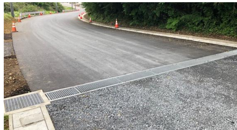
栃木県 茂木町役場 道路改築工事
