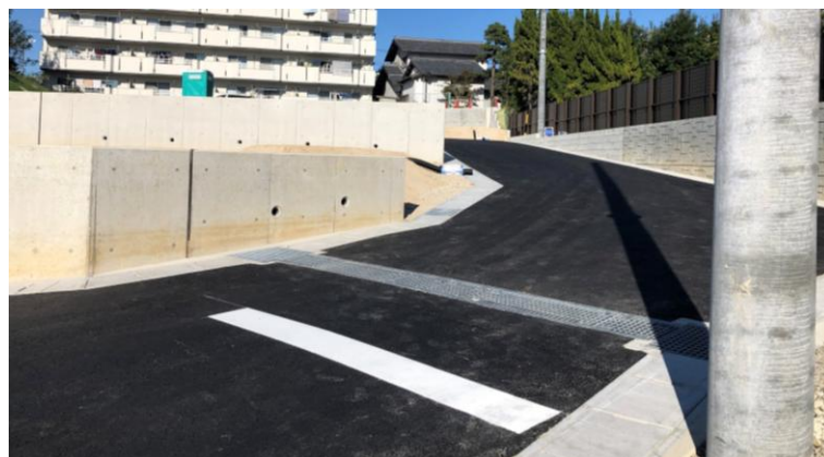
愛知県 戸崎造成工事
