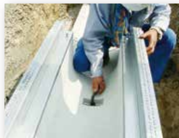
④ 固定ボルト締め
