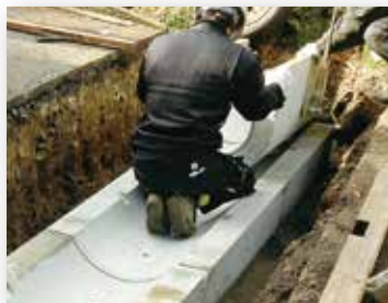
③ 側溝据え付け
