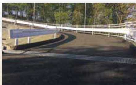
相武国道事務所
