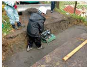
① 基礎材敷設
