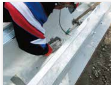
⑤ 連結部モルタル詰め
