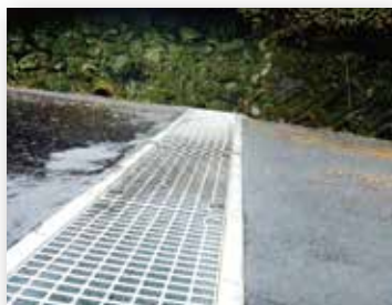
⑥ 舗装完成
