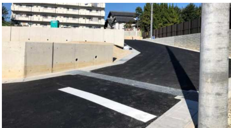
愛知県 戸崎造成工事
