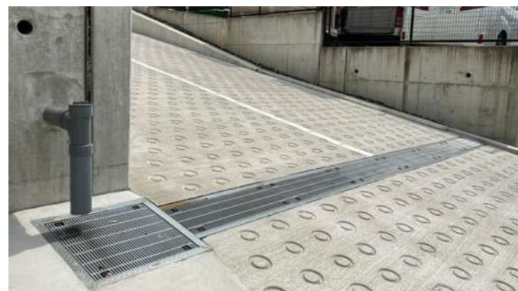
愛知県 医療法人倉橋クリニック造成工事
