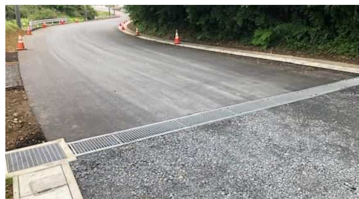
栃木県 茂木町役場 道路改築工事
