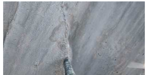
ひび割れ修復
