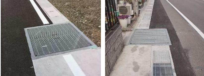
▲山梨県南アルプス市
