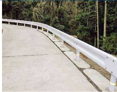
長浜土木事務所(滋賀県)
