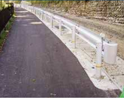
駒ヶ根市役所(長野県)
