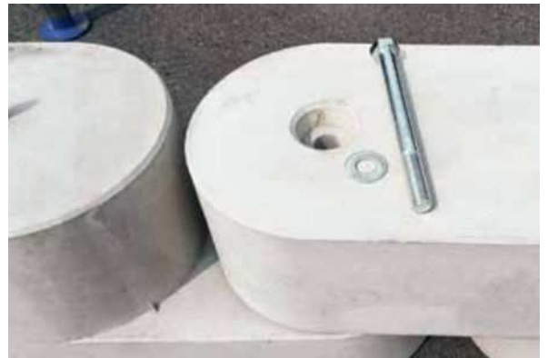
上下を連結ボルトで固定
