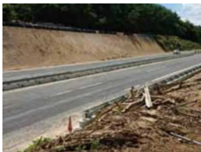
西日本豪雨災害 復旧工事にて
